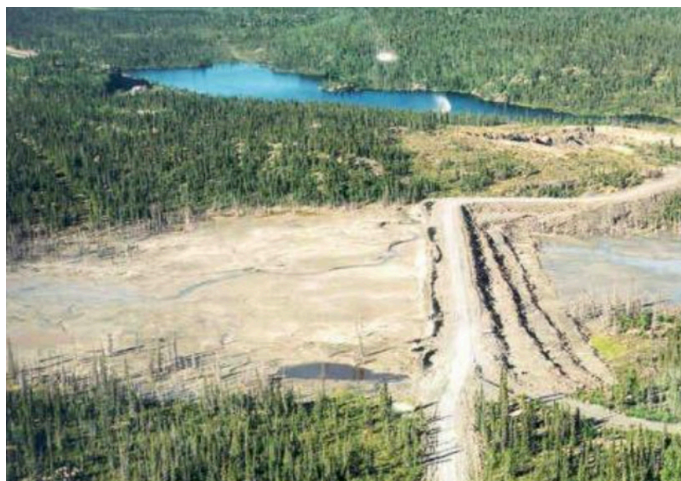
Imagen VI.3 Tranque de relave con dique
