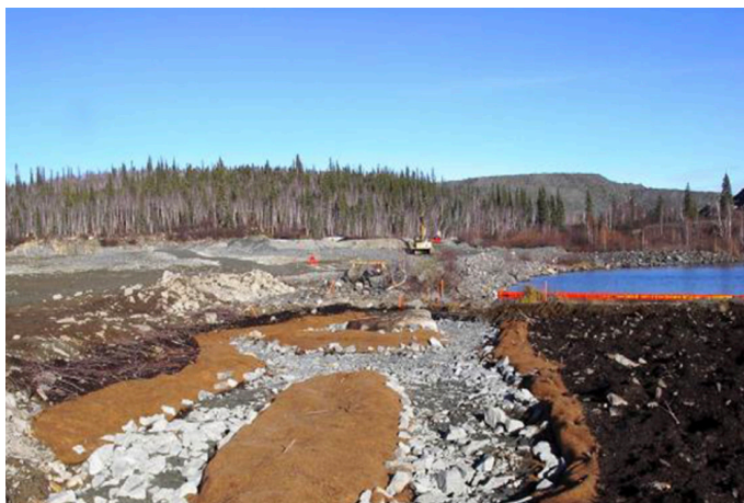
Imagen VI.4 Proyecto de remediación de Colomac
