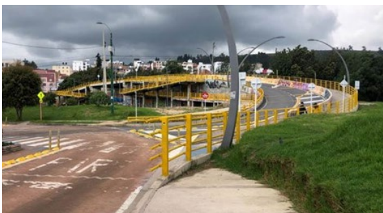
Área de ejecución de las actividades del proyecto en Tunja (Departamento de Boyacá, Colombia).
