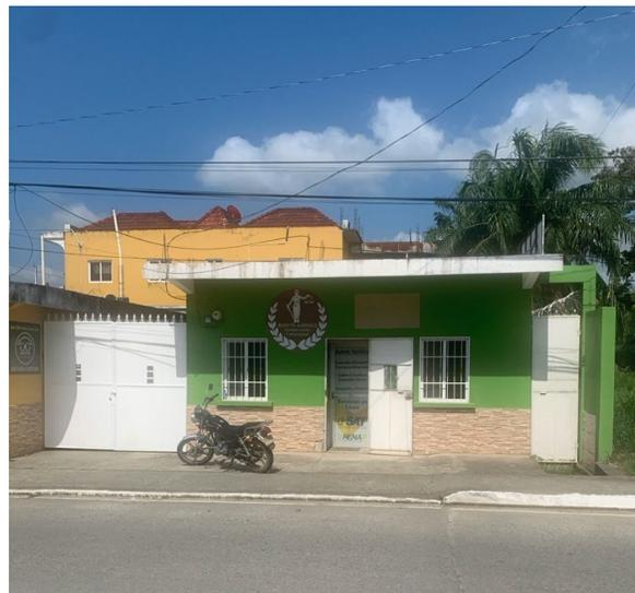
F. Tipología constructiva 7: vivienda en paredes en bloque concreto y cubierta en losa de concreto, 2 pisos o más
