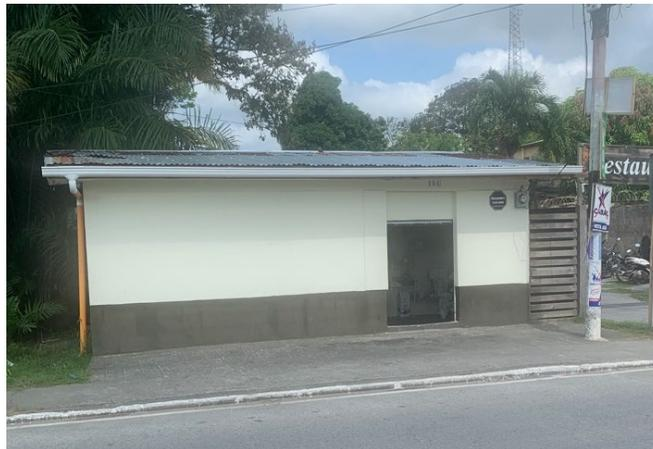
E. Tipología constructiva 6: vivienda en paredes en bloque concreto y cubierta en losa de concreto
