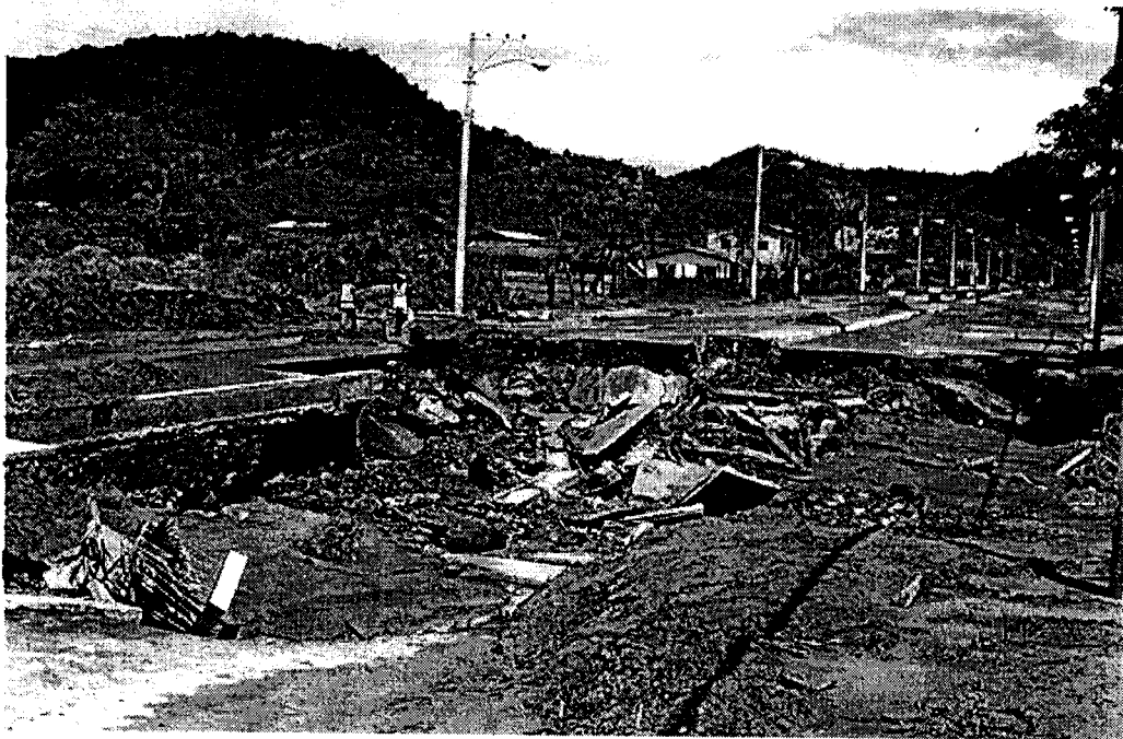
Foto 8. Provincia del Guayas. Hundimiento de carretera por socavación del subsuelo saturado de agua y falta de drenaje adecuado.
