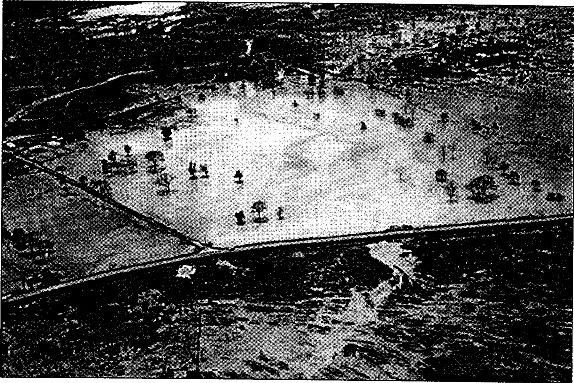
Foto 7. Provincia de Los Ríos. Ejemplo de dique formado por una carretera que al carecer de drenaje no permite la evacuación del agua.
