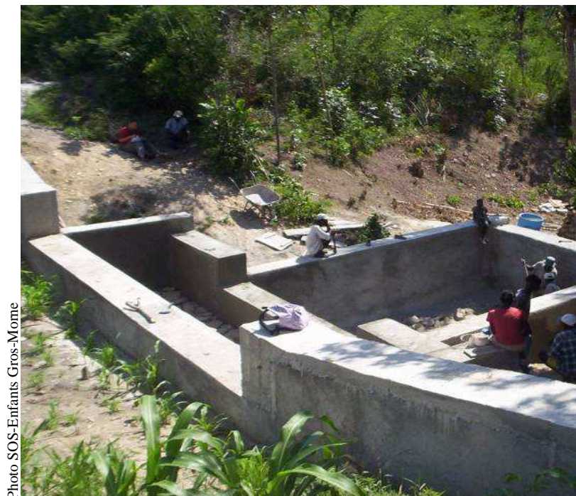
Barrage de ravine avec citerne et bassin de décantation en aval
