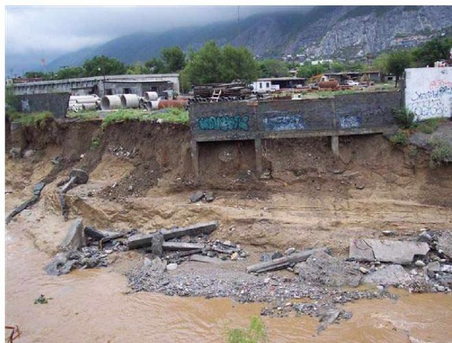
**Figura 5.18** Panorámica de los daños en el talud margen izquierda del Arroyo Topochico. Cruce Puente Rangel Frías con calle Santiago en la Col. Loma Bonita, Municipio de Monterrey
