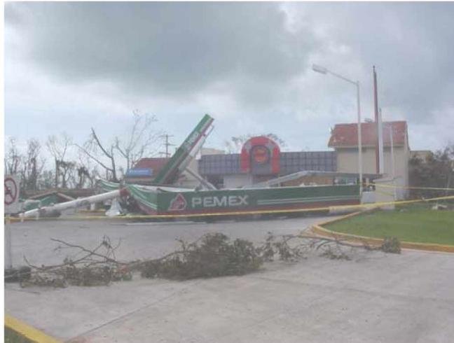
**Figura 2.11 Colapso de la estructura de la gasolinera en Puerto Aventuras**
