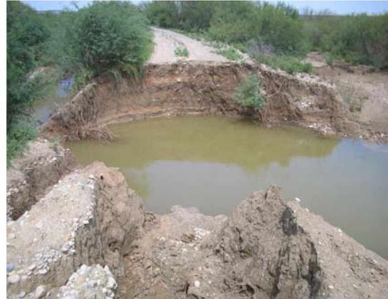
**Figura 5.10** Derrumbe en margen derecha de canal de riego en San José de Vaquerías
