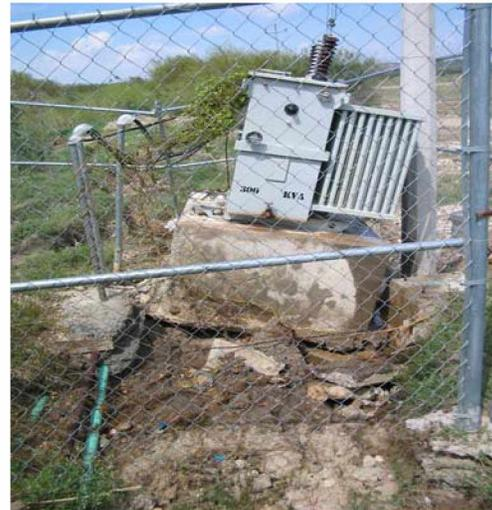
**Figura 5.12** subestación eléctrica dañada
