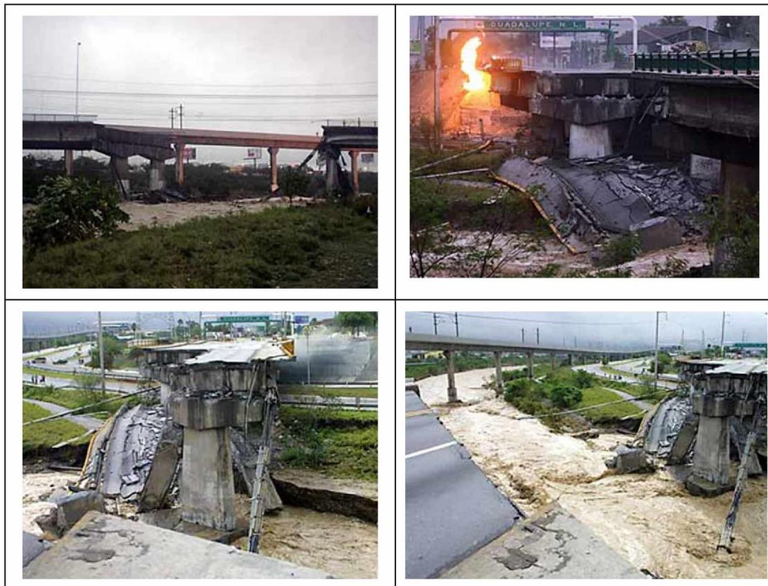
**Figura 5.24 Colapso del puente Guadalupe**
