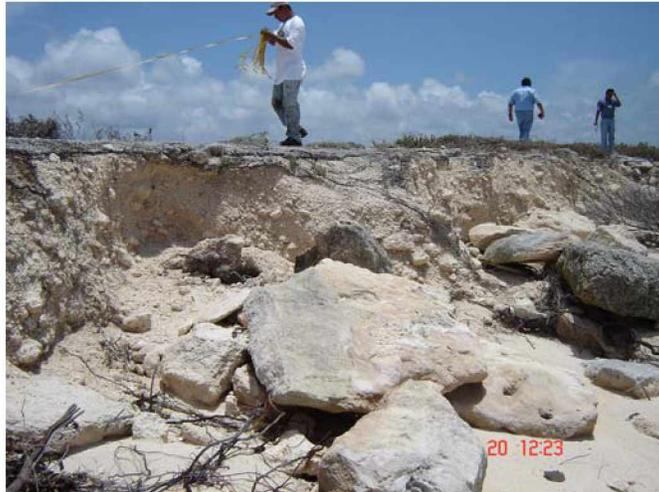
**Figura 2.13 Socavaciones generadas por la marea de tormenta de Emily en la región sur de Cozumel**
