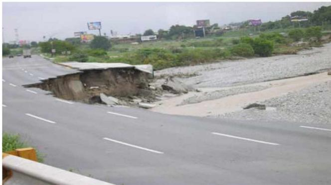
**Figura 5.17** Panorámica del cauce del Río Santa Catarina el Municipio de Guadalupe. Se aprecia socavación del talud margen derecha con afectación de 2 carriles de la avenida Morones Prieto
