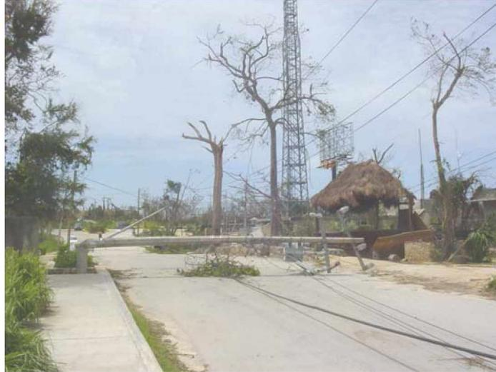
***Figura 2.9 Postes de energía eléctrica derribados por el viento del huracán Emily en el poblado de Puerto Aventuras***
