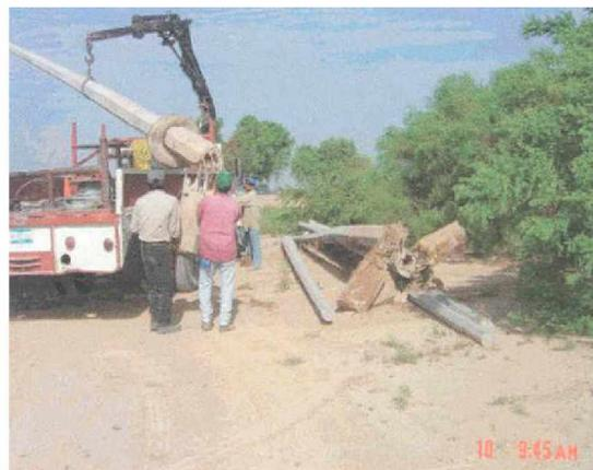
**Figura 4.18 Substitución de postes con destrucción total**
