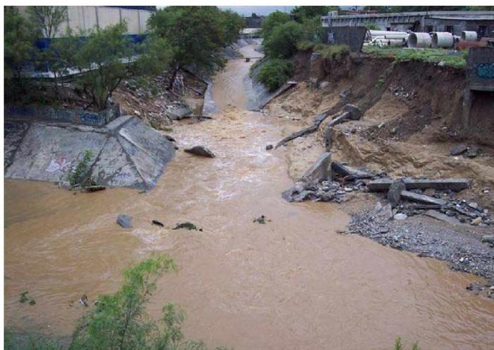
**Figura 5.15 Panorámica de los daños en ambos taludes del Arroyo Topochico. Cruce Puente Rangel Frías con calle Santiago, en la Col. Loma Bonita, Municipio de Monterrey**
