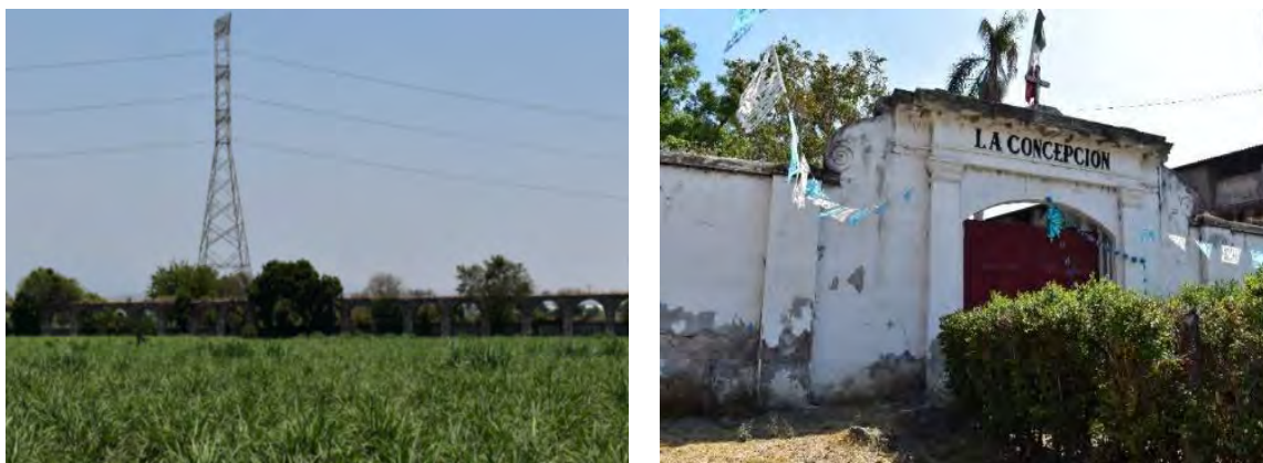
Imagen 4 Exhacienda La Concepción: acueducto y fachada principal
