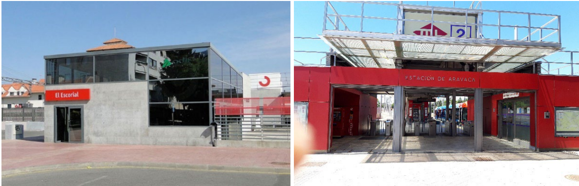
Imagen 16 Puertas accesibles en estaciones de cercanías y en intercambiadores
