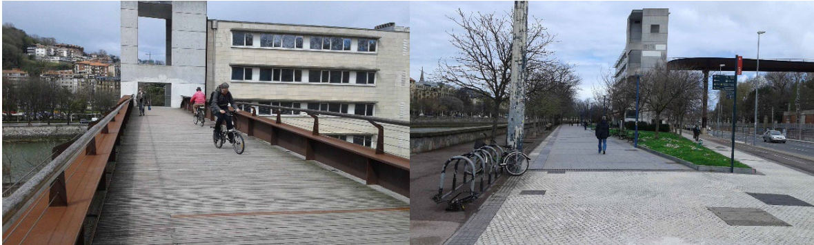
Imagen 23 Transporte vertical, entrada y edificio
