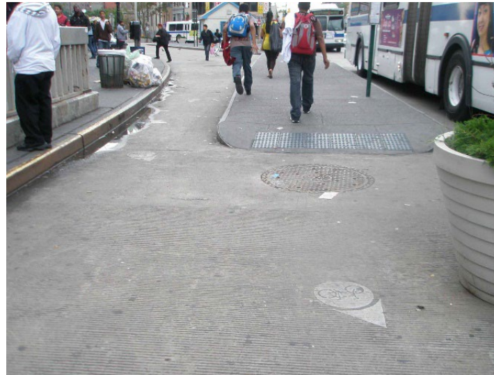
Imagen 1 Rampa de acceso a andén elevado de la parada de autobús
