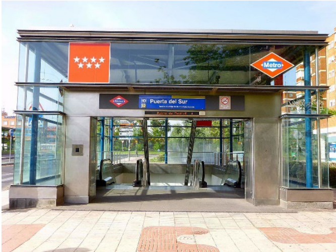
A. Estación Puerta del Sur Metro de Madrid, 2016
