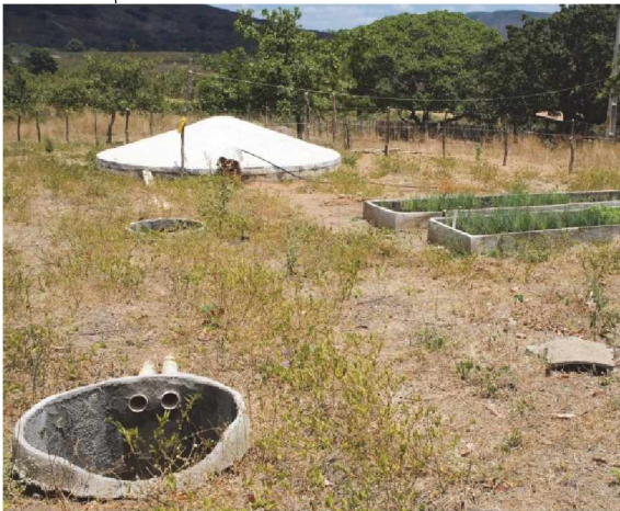
Cisterna de enxurradas de 52 mil litros
