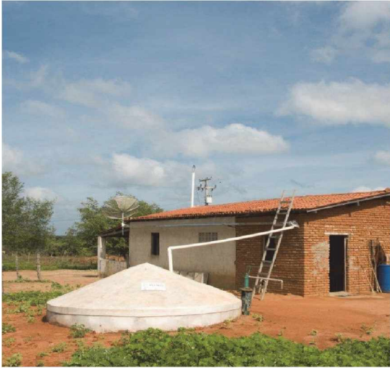
Cisterna de placas de 16 mil litros
