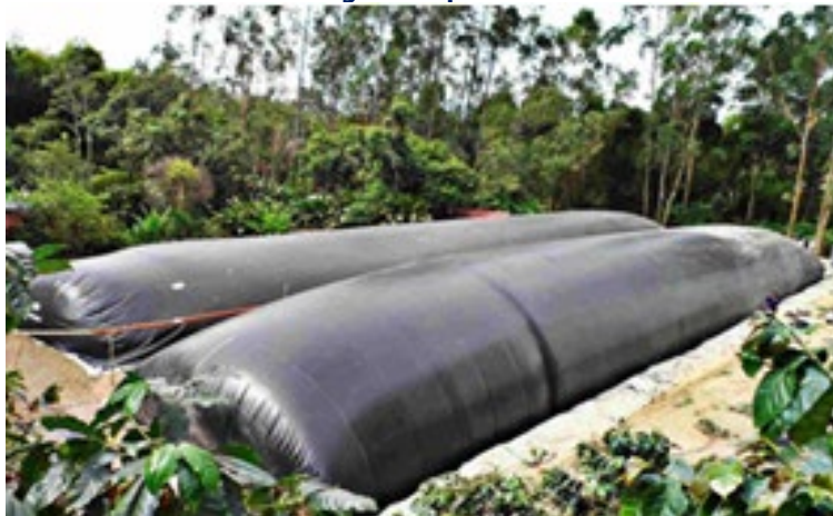
Imagen A-1 Biodigestor tipo Taiwán
