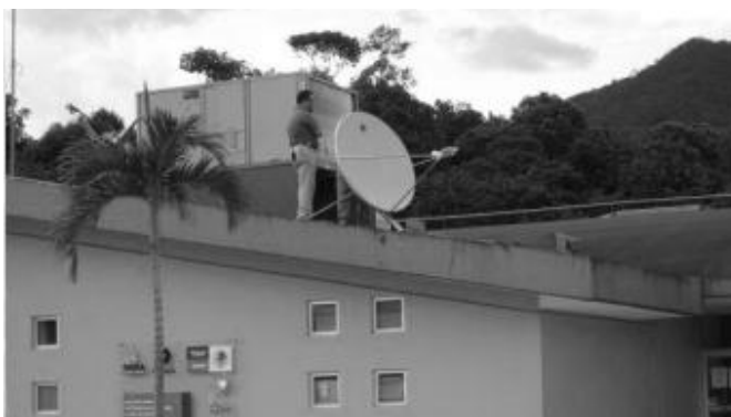
FOTOGRAFÍA II.3 LA CONEXIÓN SE REALIZA POR MEDIO DE ENLACE SATELITAL
