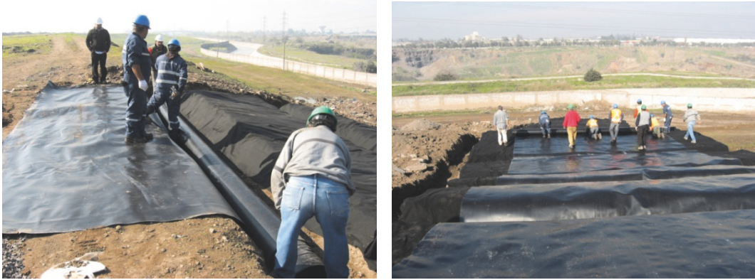
Imagen A.35 Ex vertedero Lo Errázuriz: impermeabilización de taludes
