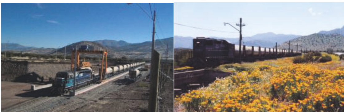
Imagen A.26 Transporte ferroviario de residuos sólidos desde la estación de transferencia al relleno sanitario
