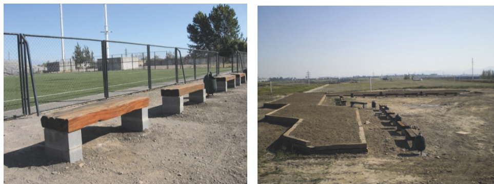
Imagen A.38 Ex vertedero Lo Errázuriz: habilitación de zonas de estar y equipamiento urbano
