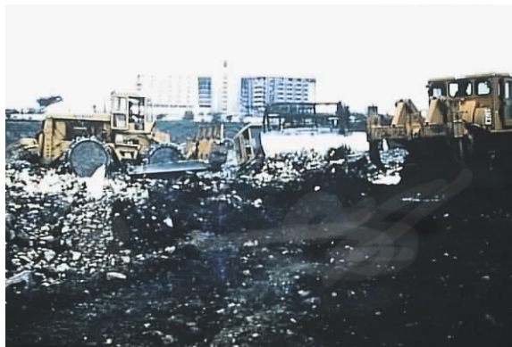
Imagen A.29 Relleno Sanitario La Feria, 1980
