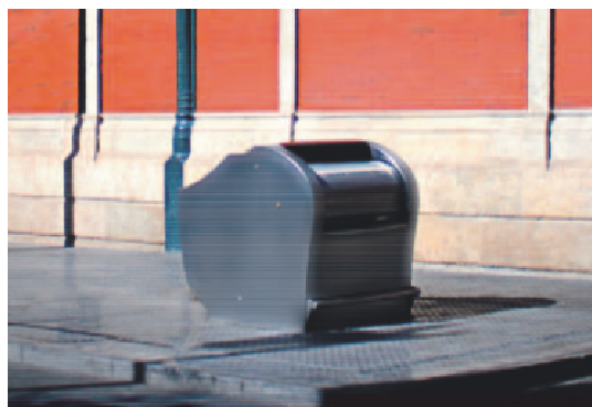
Imagen A.16 Contenedores soterrados con compactación
