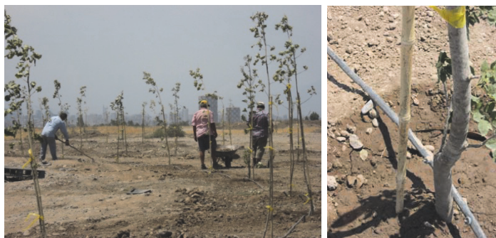
Imagen A.39 Ex vertedero Lo Errázuriz: recuperación paisajística y sistema de riego por goteo
