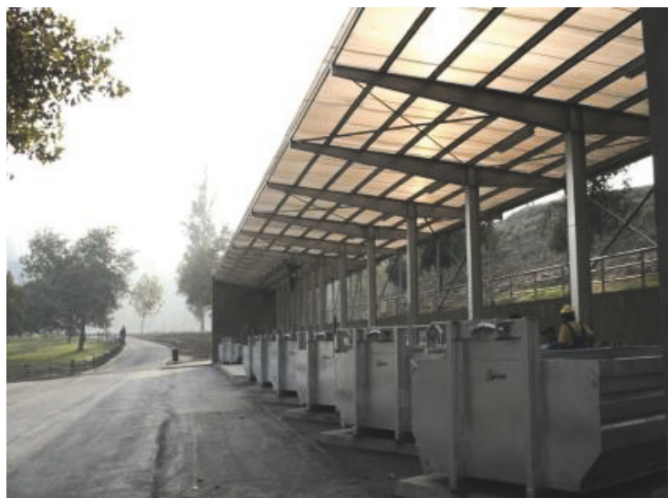
Imagen A.20 Contenedores de superficie en punto limpio
