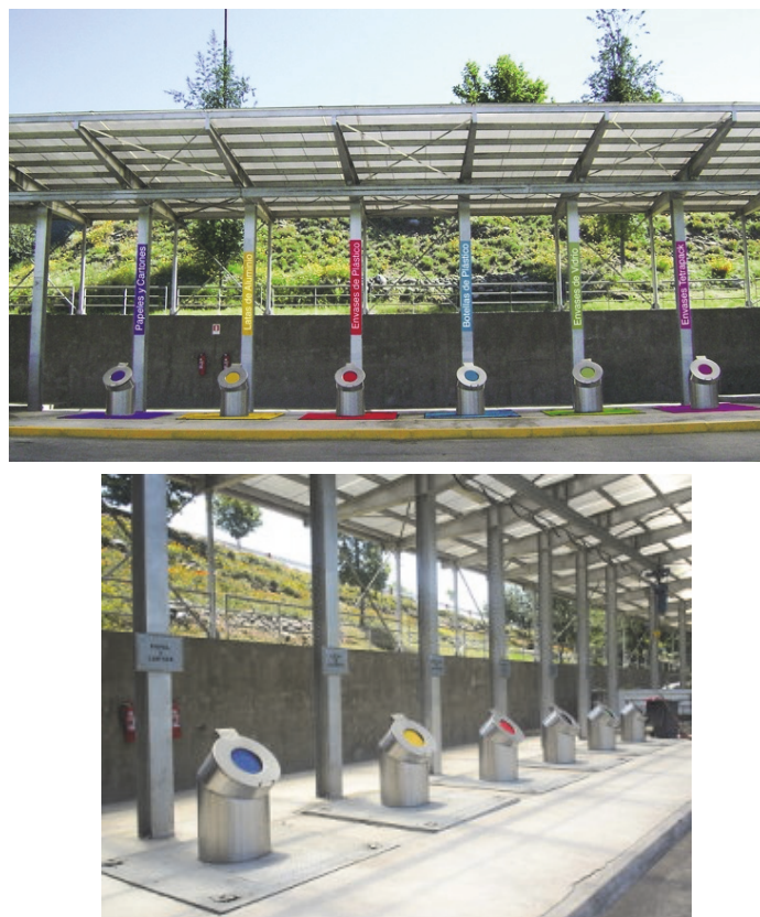
Imagen A.19 Contenedores subterráneos en punto limpio
