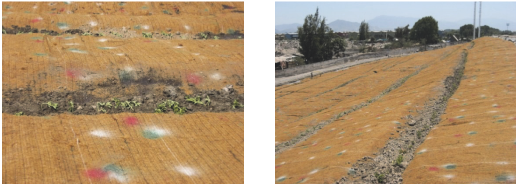
Imagen A.36 Ex vertedero Lo Errázuriz: geomanta (malla de fibra de coco) instalada
