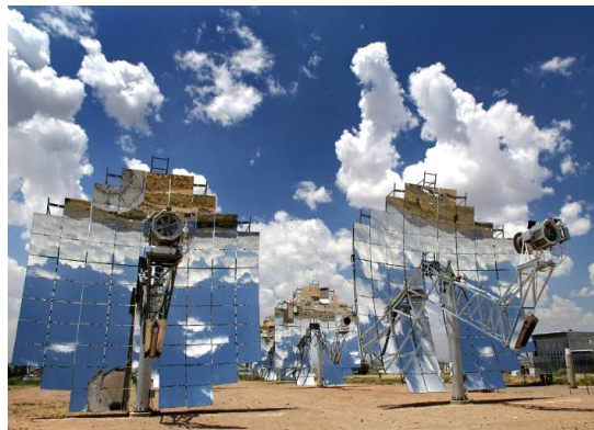
FIGURA 20 VISTA DE LAS UNIDADES DE CONVERSIÓN DE LA PLANTA SOLAR CON DISCOS PARABÓLICOS Y MICRO-TURBINA EN ALBUQUERQUE, NEW MEXICO, USA
