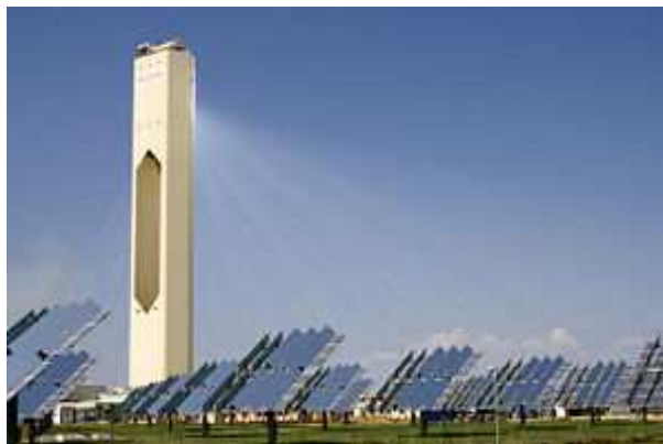
FIGURA 16 VISTA DE LA PLANTA PS10 EN LAS CERCANÍAS DE SEVILLA, ESPAÑA
