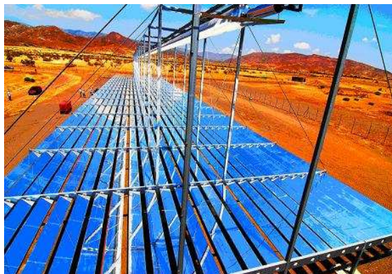
FIGURA 12 VISTA DE UNA PLANTA LINEAR CON SISTEMA “FRESNEL”
