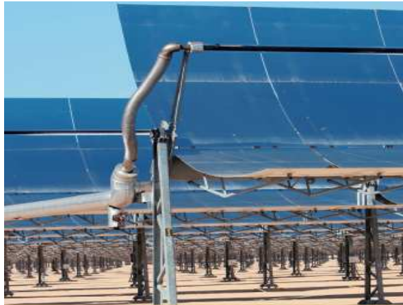
FIGURA 5 COLECTOR PARABÓLICO EN UN CAMPO SOLAR TERMODINÁMICO
