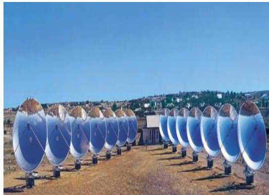
FIGURA 19 VISTA DE LA PLANTA SOLAR CON DISCOS PARABÓLICOS EN WHITE CLIFFS, AUSTRALIA
