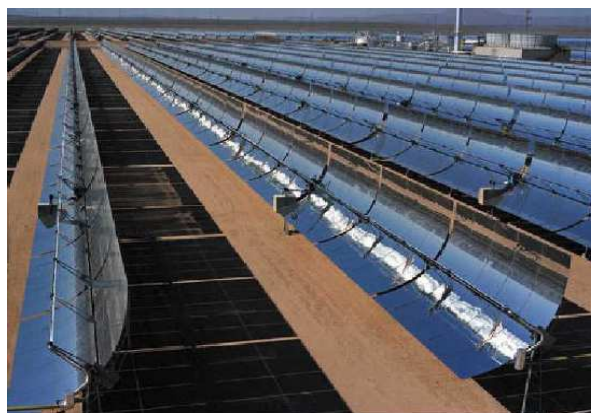
FIGURA 10 VISTA DEL CAMPO SOLAR SEGS IV UBICADO EN CALIFORNIA, USA
