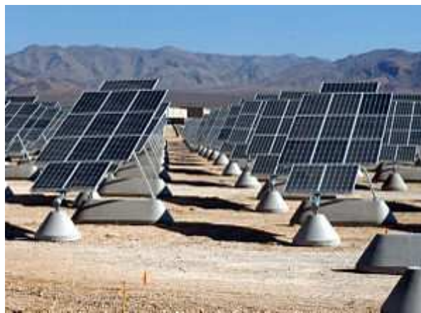
FIGURA 4 CAMPO SOLAR DE PANELES PV – NELLIS AIR FORCE BASE, USA
