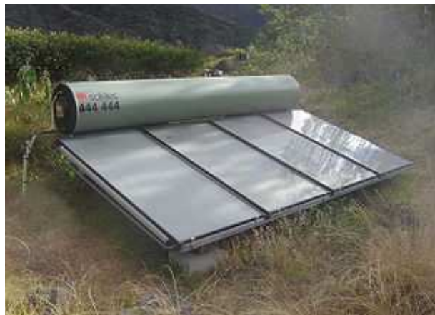
FIGURA 3 PANEL SOLAR TÉRMICO A CIRCULACIÓN NATURAL
