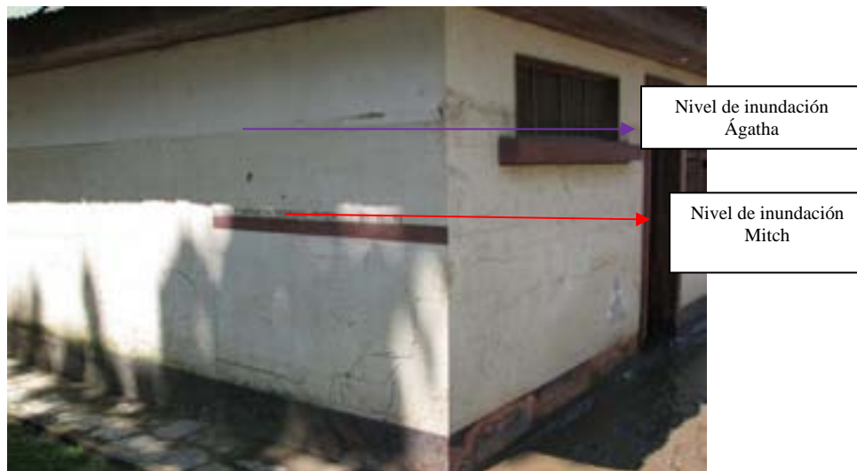
FOTO 6 GUATEMALA: COMPARACIÓN ENTRE EL NIVEL DEL AGUA ALCANZADO POR LA TORMENTA MITCH DE 1998 Y LA TORMENTA ÁGATHA DE 2010
