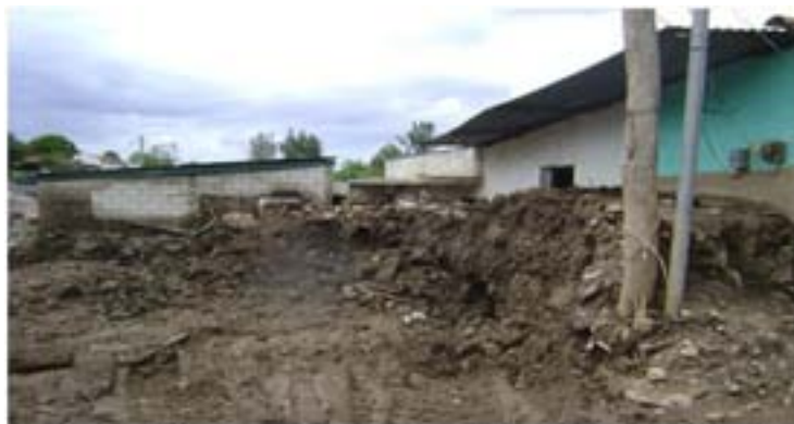
FOTO 5 GUATEMALA: VIVIENDAS DESTRUIDAS Y EN RIESGO, 2010
