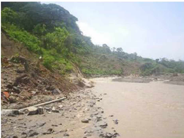
FOTOGRAFÍA 37 CALLE A BARRA DE SANTIAGO, AHUACHAPÁN, CAUSA: DESBORDAMIENTO DE RÍOS
