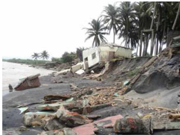
FOTOGRAFÍA 25 VIVIENDA AFECTADA CON DAÑOS TOTALES EN MUNICIPIO DE SAN PEDRO MASAHUAT, DEPARTAMENTO DE LA PAZ
