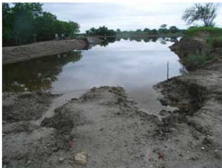
FOTOGRAFÍA 23 ESTANQUE DAÑADO EN EL BAJO LEMPA
