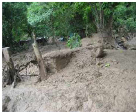
FOTOGRAFÍA 7 DAÑOS A LAS PRIMERAS VIVIENDAS DEL CANTÓN EL ZAPOTAL
