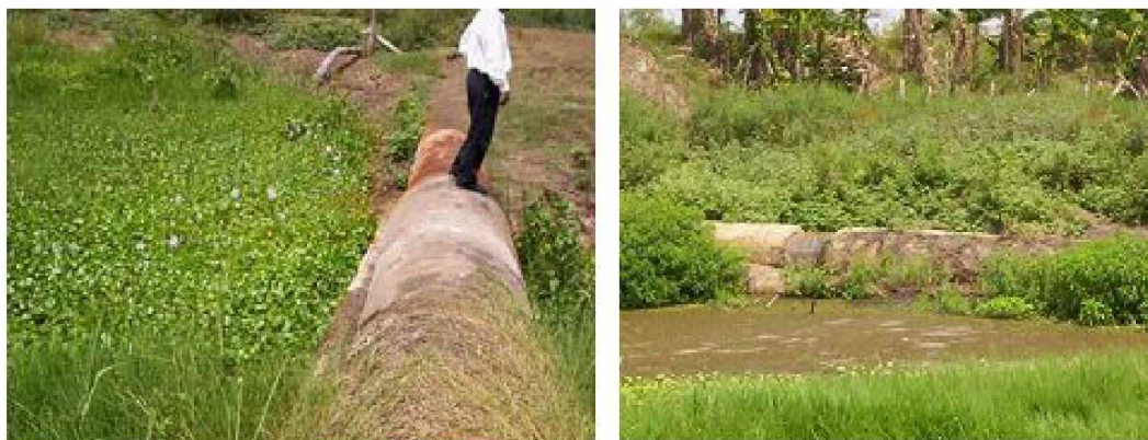
Figura 17 Ductos de PEMEX que al cruzar corrientes de agua reducen su sección hidráulica
