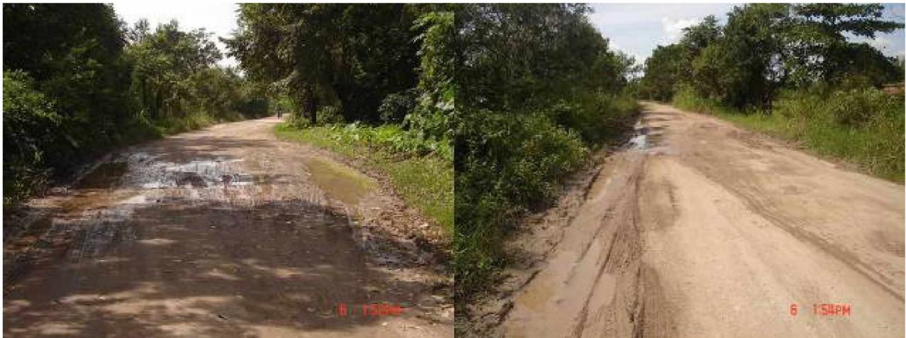
Daños en el camino Pejelagarto – Palo Mulato (plataforma Buena Vista), en el municipio de Huimanguillo (foto cortesía de la Junta Estatal de Caminos).
