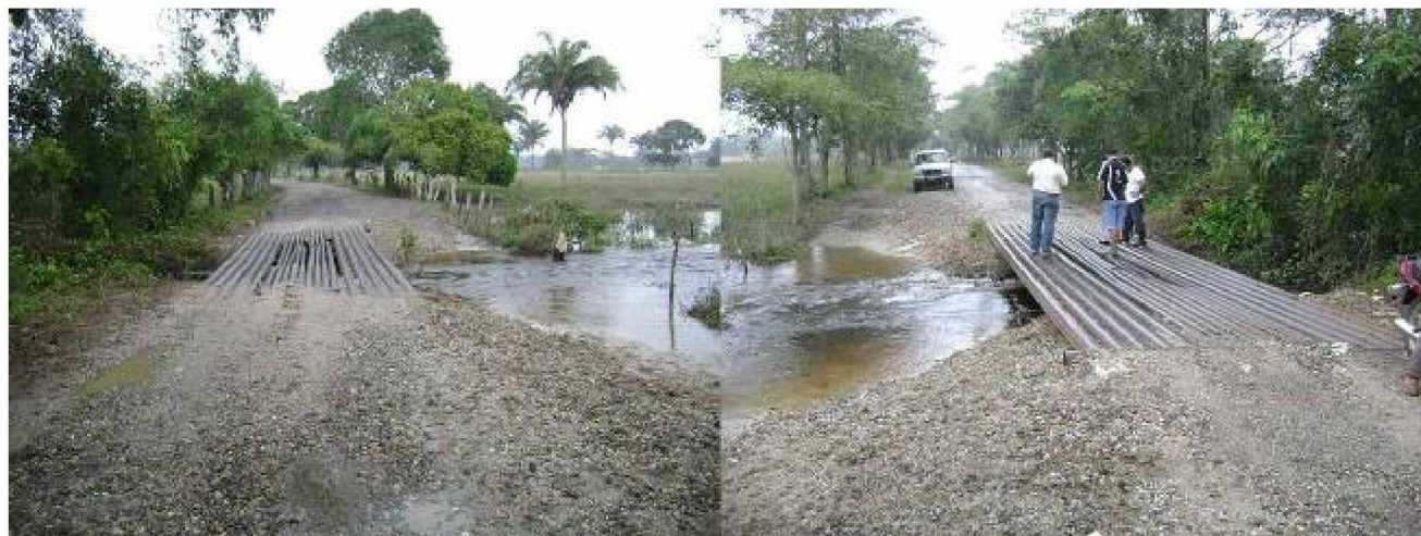
Daños en el puente tubular vehicular del camino Zanapa, segunda sección, kilómetro 3 + 400, municipio de Huimanguillo (foto cortesía de la Junta Estatal de Caminos).
