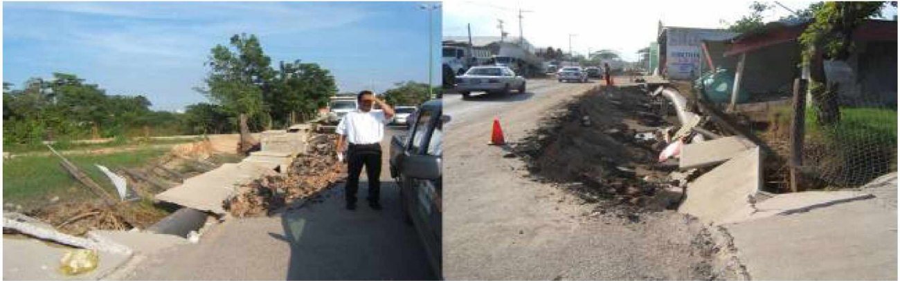
Daños en el camino Periférico Carlos Pellicer Cámara, tramo de la glorieta Carlos A. Madrazo al Puente Tec Milenio, en el Municipio Centro (foto cortesía de la Junta Estatal de Caminos).
