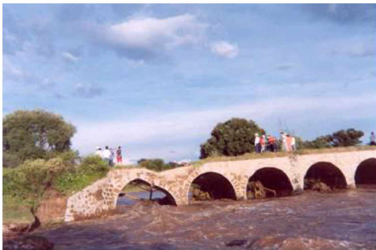
Figura 6.12 Puente dañado por las lluvias torrenciales en el municipio de Aquiles Serdán.
