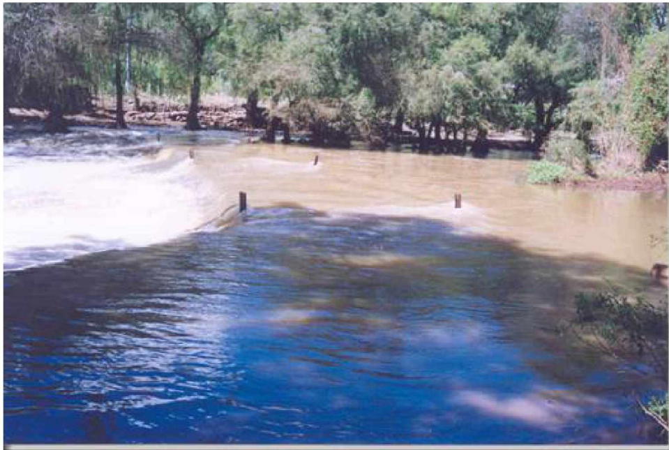
Figura 3.32 Tramo de camino inundado por crecida del río.
