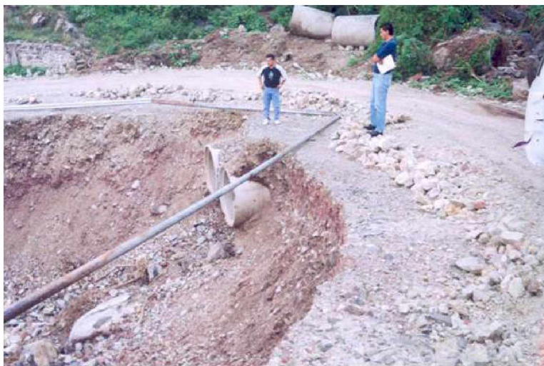
Figura 3.31 Deslave de camino y destrucción de alcantarillado.
