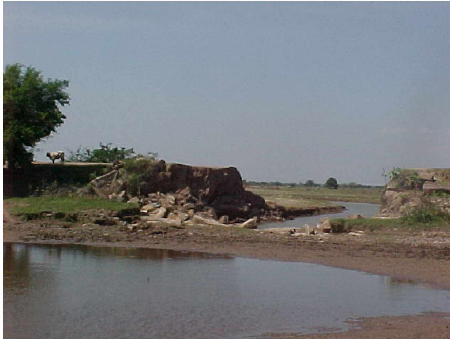
Rotura del bordo de protección de áreas productivas en la zona de Tecuala-Quimichis, en la margen derecha del río Acajoneta. La longitud de la rotura es de 15 m, está ubicada en el km 3+450 y fue provocada por filtraciones y tubificación durante la ocurrencia del caudal máximo, el día 6 de septiembre, Vista desde el talud mojado hacia el talud seco. Obsérvese la protección de enrocamiento.
