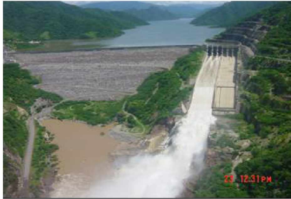
Figura 5.36 desfogue de la presa Aguamilpa.
