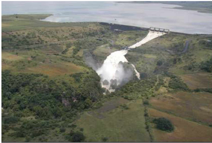
Figura 4.21 Apertura de compuertas de una de las presas del estado de Michoacán.
