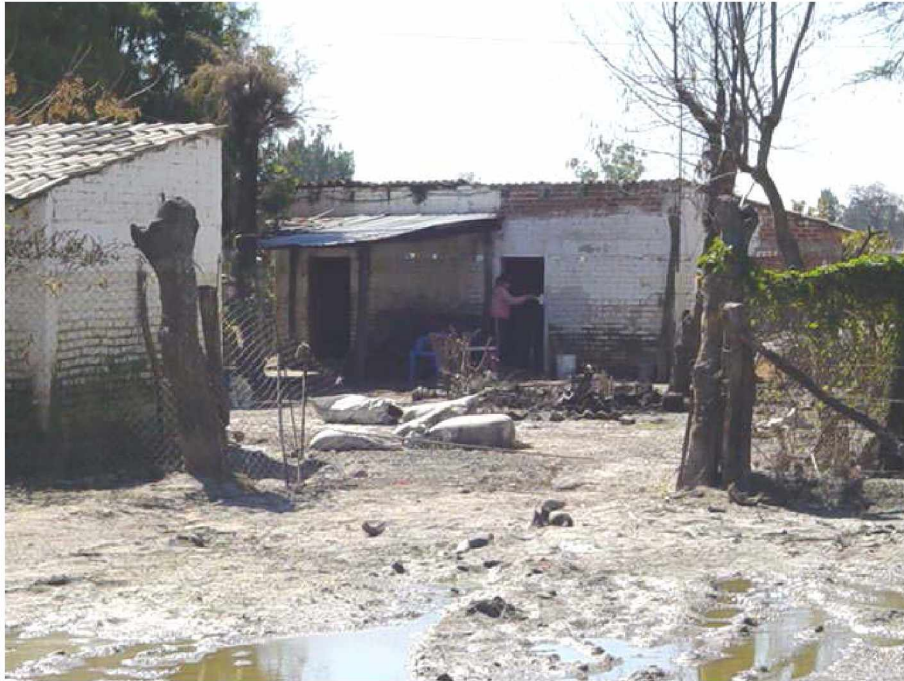
Foto 11 Viviendas de la localidad Estación Abasolo que sufrieron inundaciones.
