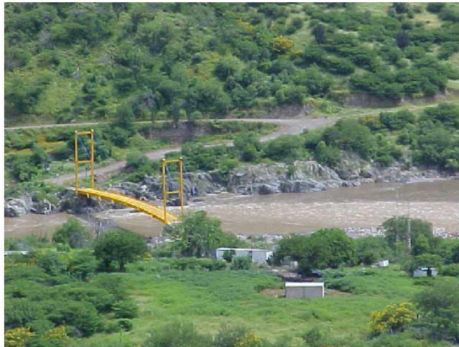
Figura 5.21 Vista del puente Paso de La Yesca, antes de su falla.
