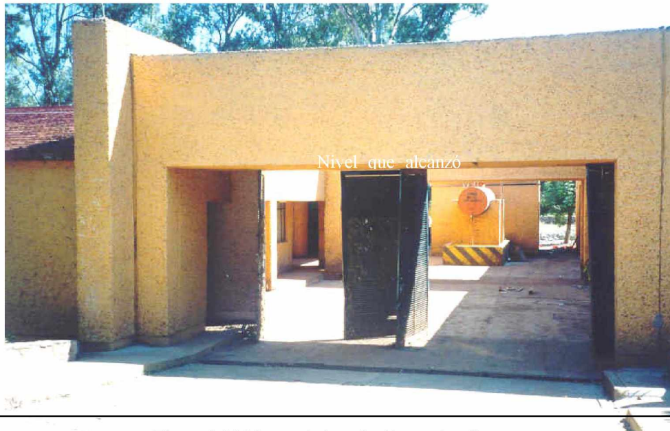
Figura 3.25 Marcas de inundación en el anfiteatro.
