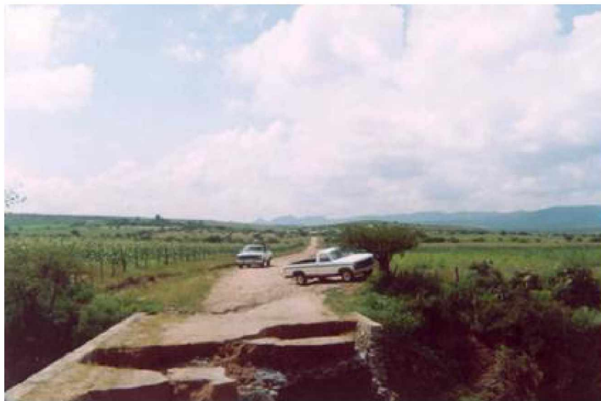
Figura 6.13 Camino dañado por las lluvias torrenciales.
