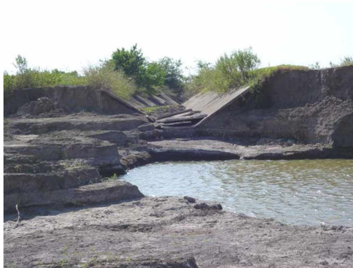
Figura 5.25 Rompimiento del canal de riego.
