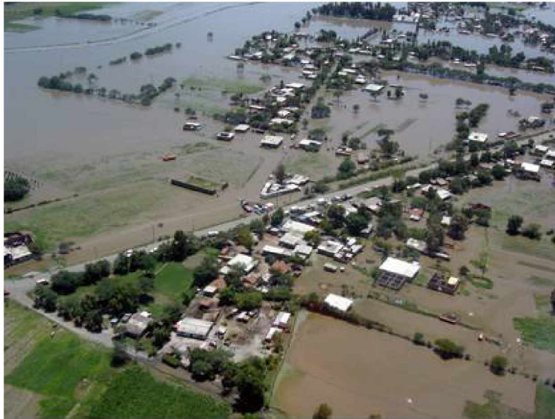
Figura 2.22 Viviendas afectadas por la inundación.
