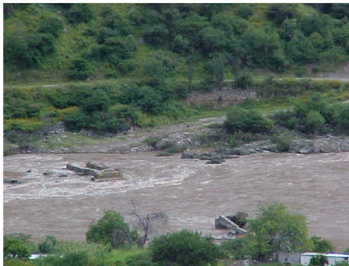
Figura 5.22 Lugar donde se encontraba el puente Paso de La Yesca.
