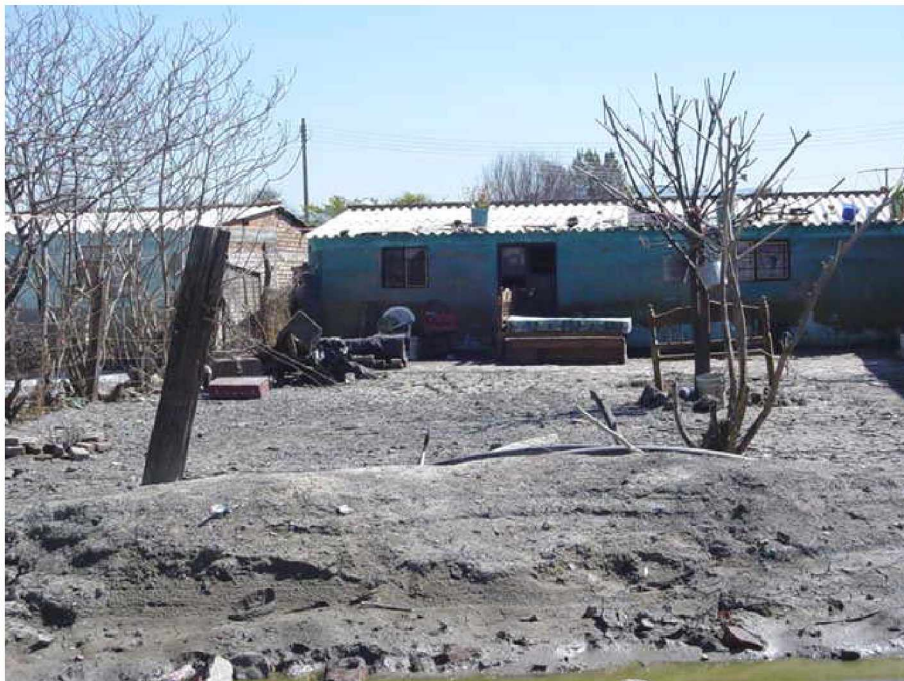
Foto 12 Depósito de sedimentos arrastrados por las corrientes de septiembre de 2003 cerca de la estación Abasolo.
