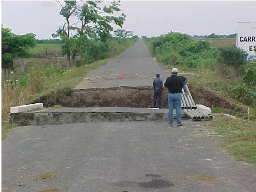
Vista puente km 2+640 dren Villa Juárez IV-2, colapsado por la avenida del río Santiago.
