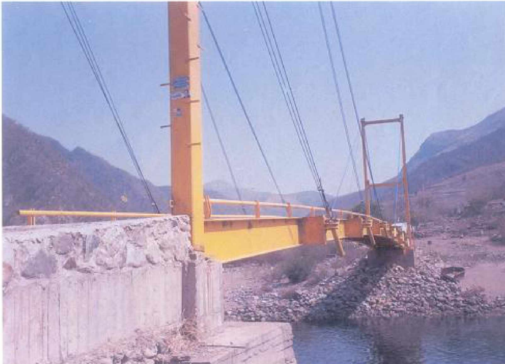
Figura 5.38 a Puente “Paso La Yesca” antes de la avenida del Río Santiago.
