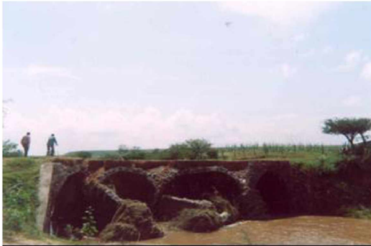
Figura 6.11 Puente dañado por las lluvias torrenciales en el municipio de Fresnillo.
