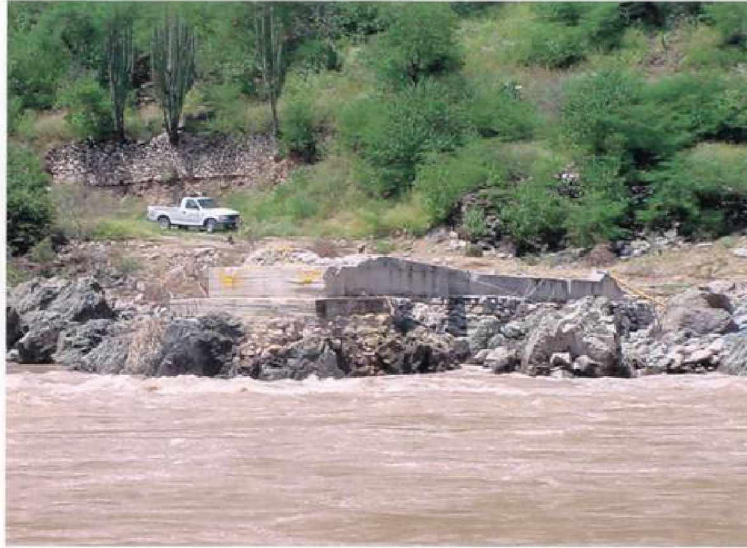
Figura 5.38b Fotografía tomada después de que el puente “Paso La Yesca” fue arrasado por la avenida del Río Santiago.
