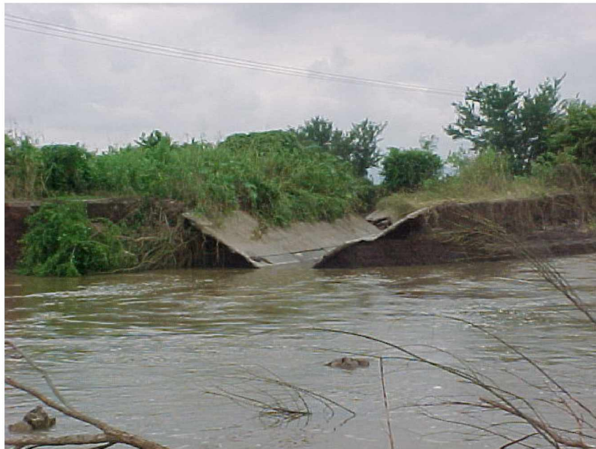
Erosión en taludes por la rotura, km 17+200 del canal lateral km 7+325 derecho del canal principal, en la unidad de riego margen derecha del río Santiago, provocado por las avenidas del río Santiago (septiembre de 2003).
