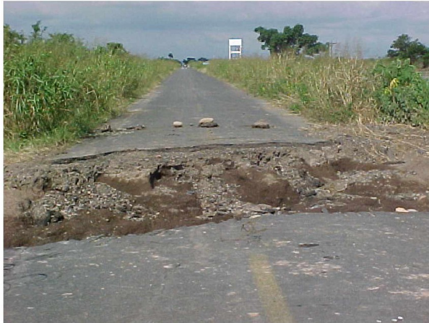
Vista aguas arriba rotura carretera km 24+500 lateral 7+325.
