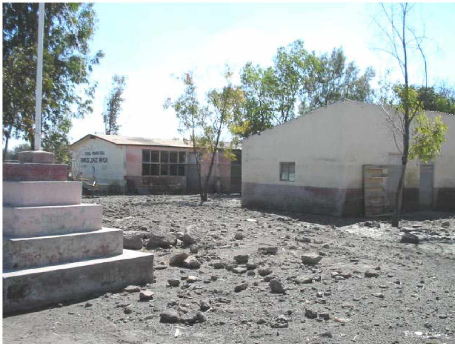
Foto 10 Escuela primaria afectada por las inundaciones en Abasolo.
