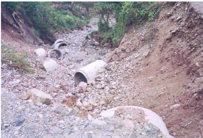
Figura 3.30 Destrucción de líneas de drenaje a causa de las inundaciones
