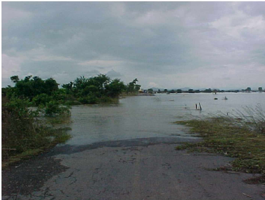
Vista aguas arriba rotura km 17+200 canal lateral km 7+325.
