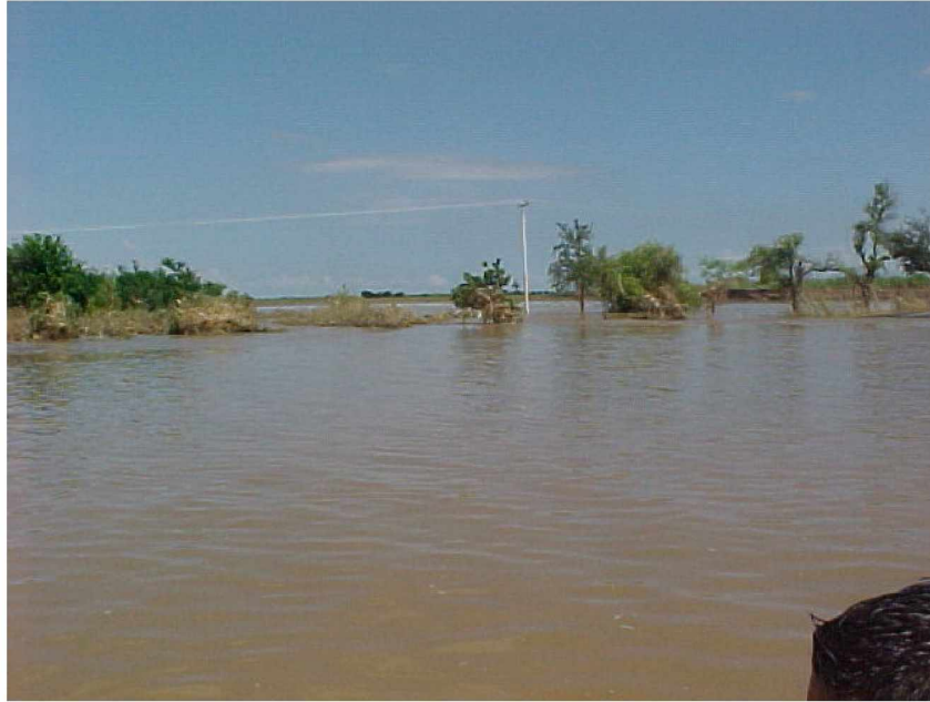
Panorámica del daño al canal lateral 7+325 izquierdo, del canal principal, en la unidad de riego en la margen derecha del río Santiago, km 16+204
