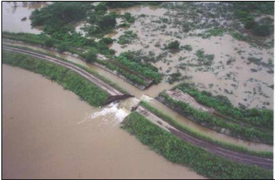
Figura 5.37 Corte de circulación por socavación del camino.
