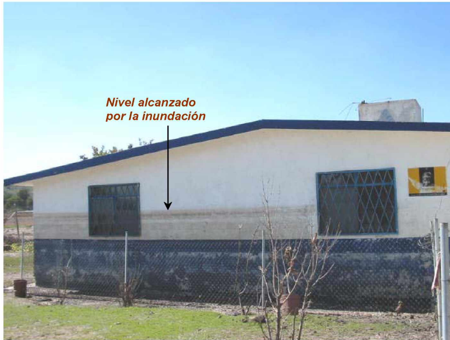
Foto 5 Centro de Salud afectado por las inundaciones en Abasolo, Gto.
