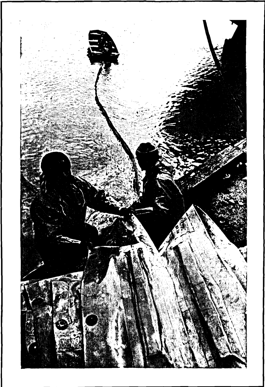
FOTO 5-1 - Despliegue de una barrera desde un muelle
