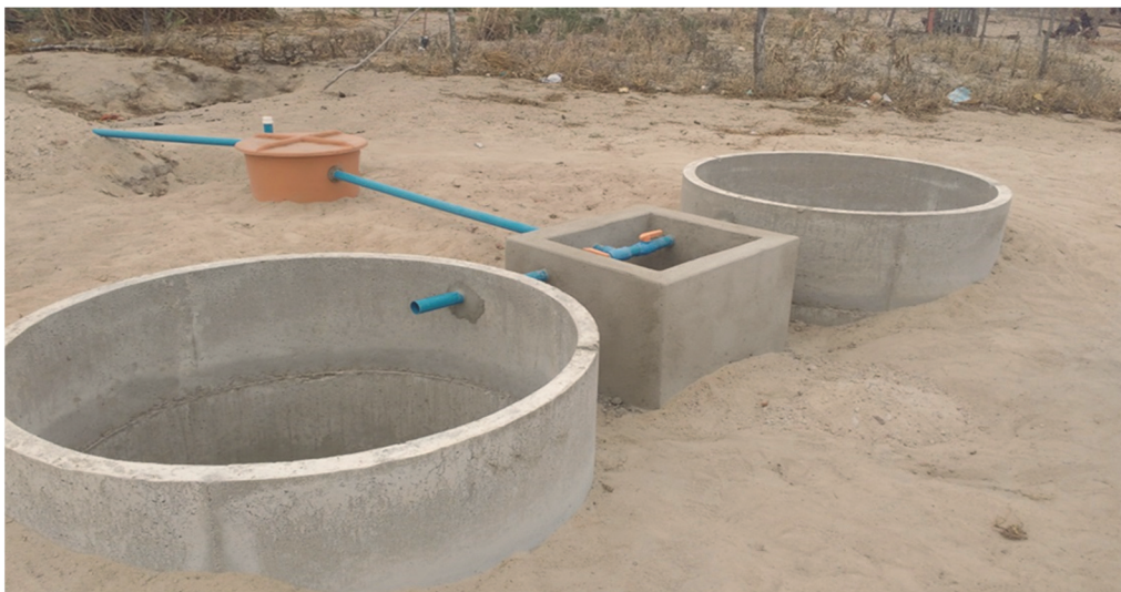
Figura VI.3 Lagoas de polimento projetadas para o estudo
