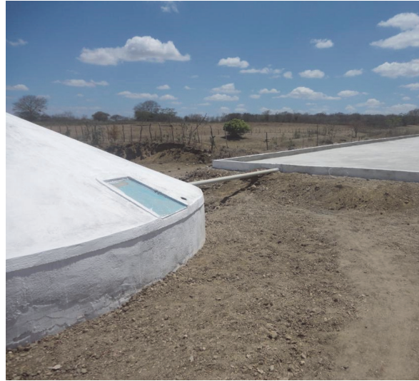
Cisterna calçada de 52 mil litros
