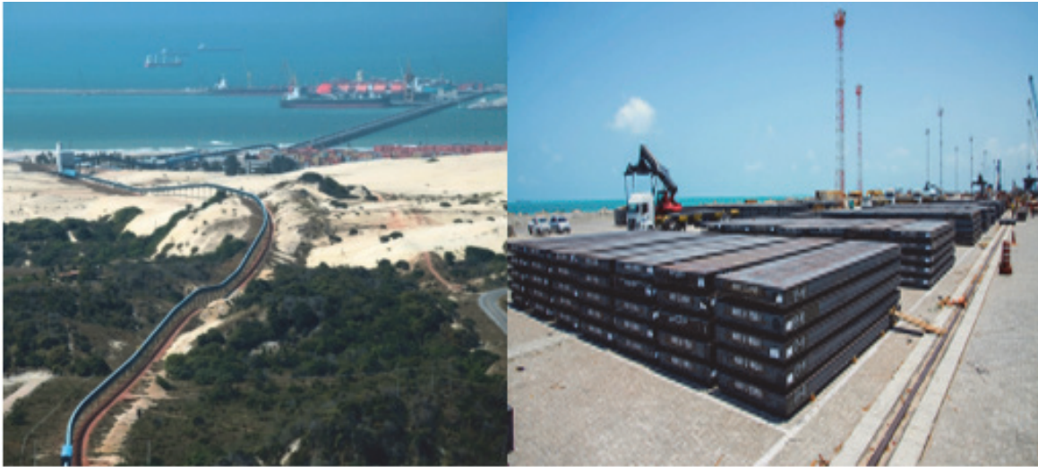
Figura I.2 Correia transportadora enclausurada responsável pelo transporte das principais matérias-primas do Porto para CSP e placas da CSP no Porto do Pecém
