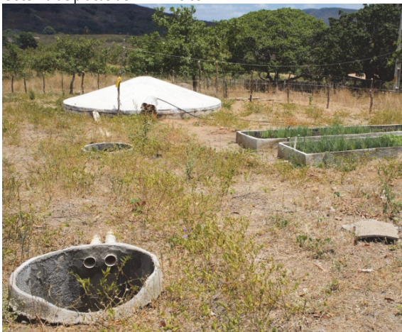
Cisterna de enxurradas de 52 mil litros
