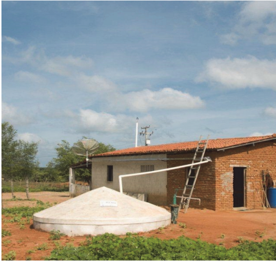
Cisterna de placas de 16 mil litros
