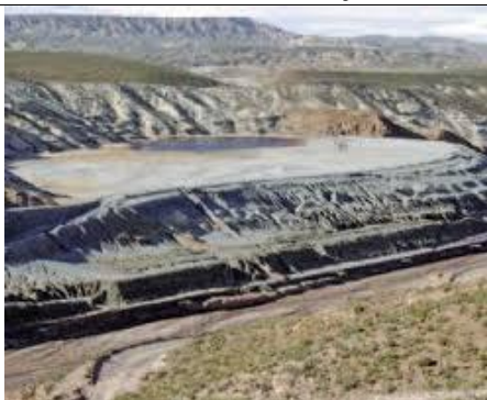
Dique antes de la remediación Fuente: Guillén & Rodríguez, 2011.
