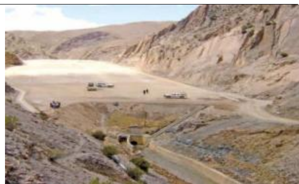
Dique después de la remediación Fuente: Guillén & Rodríguez, 2011.
