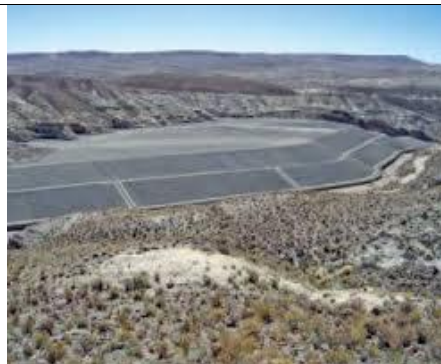
Dique después de la remediación Fuente: Guillén & Rodríguez, 2011.
