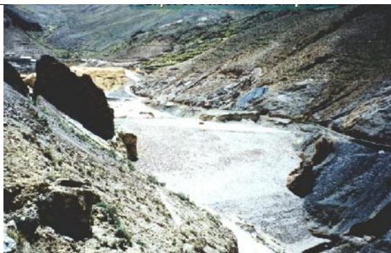
Dique después de la remediación Fuente: COMIBOL, 2007.
