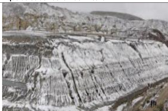
Dique antes de la remediación Fuente: Guillén & Rodríguez, 2011.
