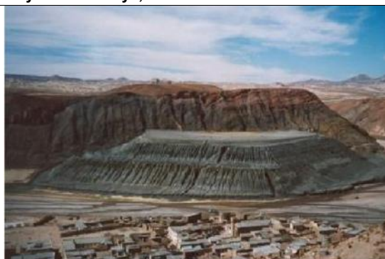
Vista del Dique de Colas Nuevo antes de la remediación Fuente: COMIBOL, 2007
