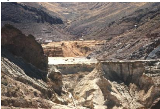
Dique antes de la remediación Fuente: COMIBOL, 2007.
