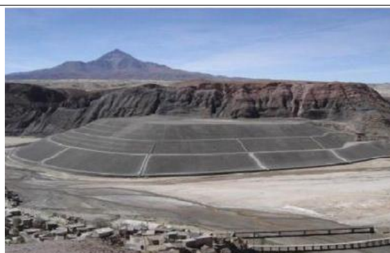
Dique de Colas Nuevo una vez finalizado el Proyecto Fuente: COMIBOL, 2007
