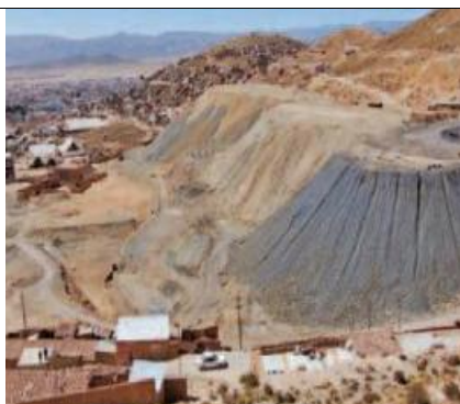
Sector antes de la remediación Fuente: Guillén y Rodríguez, 2011.
