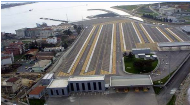
FIGURA 14 TERMINAL RORO - ESTAMBUL
