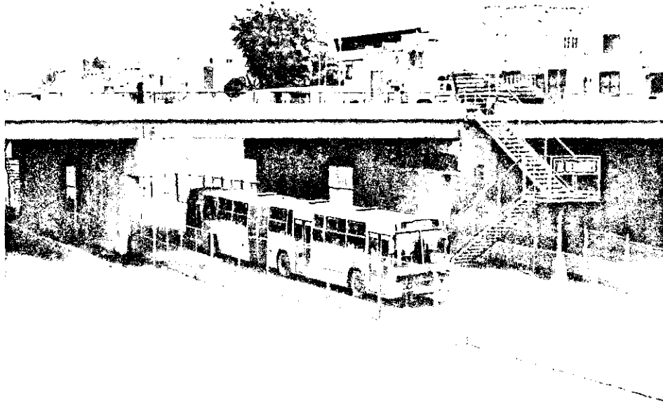
Figura 5. La estación São Pedro. En las pistas exclusivas tipo COMONOR de Porto Alegre, los omnibuses se detienen en estaciones con espacio para acomodar los convoyes y equipadas para proteger los pasajeros del clima y . Observese el diseño escalonado, que reduce el ancho de la avenida ocupada por la estación.
