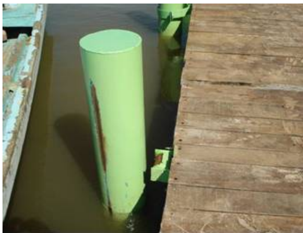
FOTOGRAFÍA 36 MUELLE AFECTADO POR LA INUNDACIÓN
