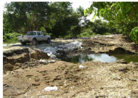
f) Puente sobre el camino Federico Álvarez – José Colomo, municipio de Jonuta
