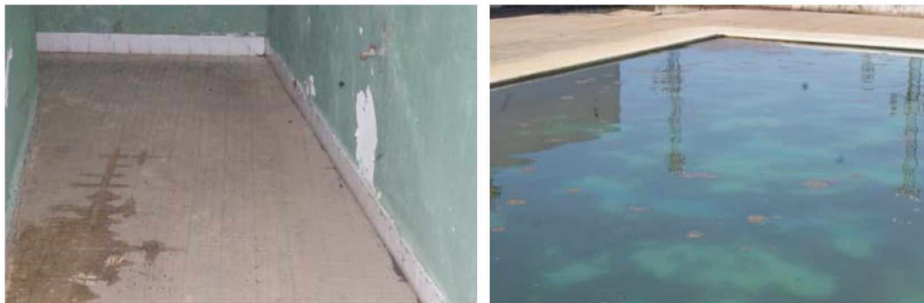
FOTO 24 TABASCO: DAÑOS EN LA ALBERCA MUNICIPAL DE JALAPA
