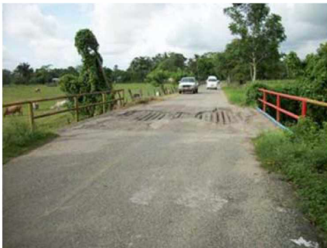
c) Afectación en superficie del puente sobre el camino Iquinapa – El Clavo, municipio de Jalpa de Méndez
