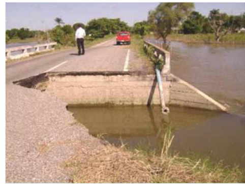
d) Daño en puente Frontera – Jonuta, municipio de Centla
