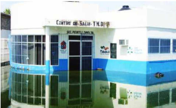
FOTO 13 DAÑOS SECTOR SALUD
