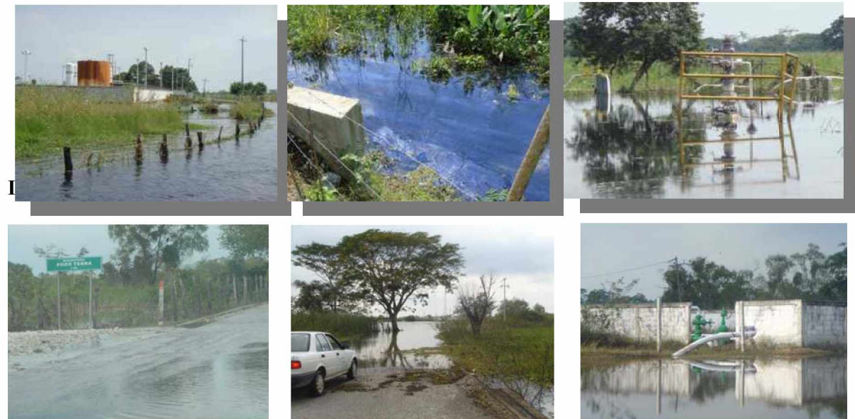
FOTO 30 TABASCO: INSTALACIONES PETROLERAS DEL CAMPO SEN
