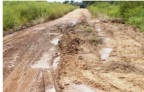
b) Daño en camino Nuevo Pochote, municipio de Emiliano Zapata
