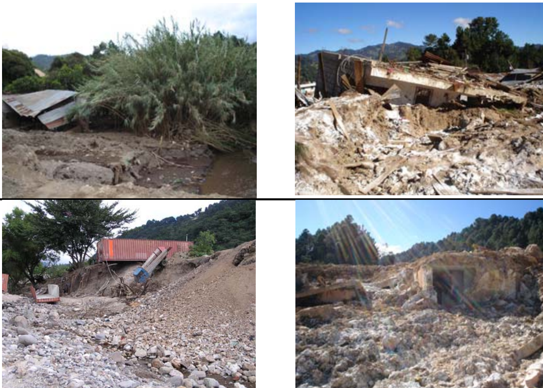
Cuadro 5. Afectación en Viviendas
