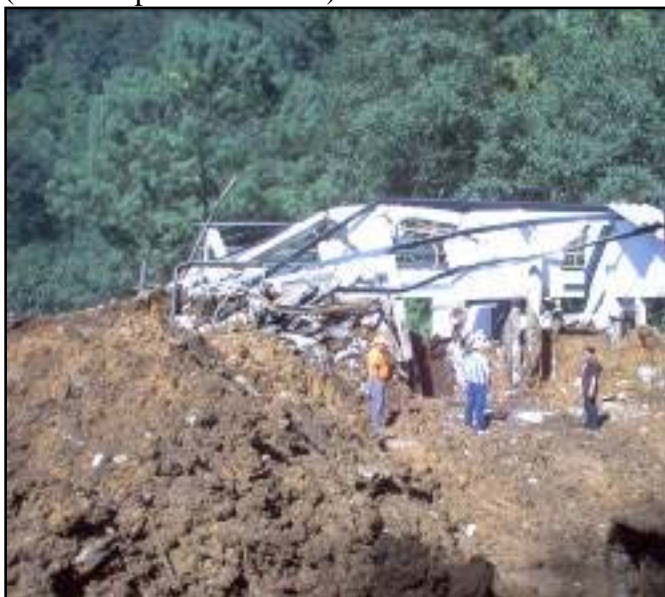
Foto: Puesto de Salud Agua Escondida Departamento de Quiché MSPAS – Guatemala
