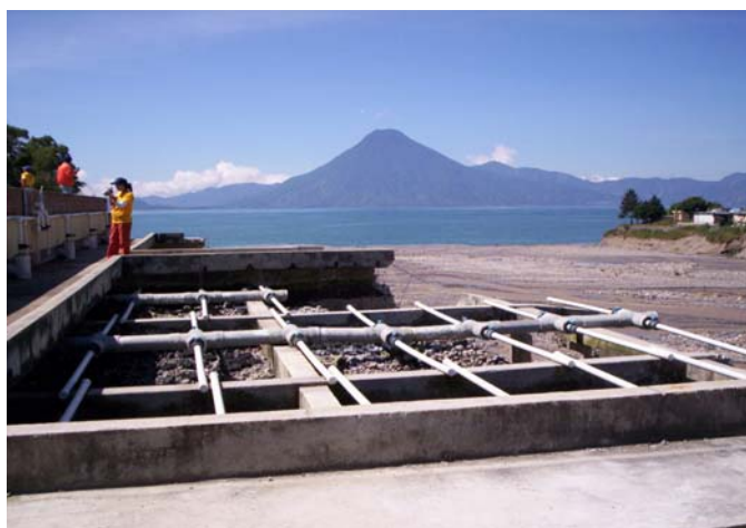
Planta de tratamiento de Aguas Residuales, Panajachel,
