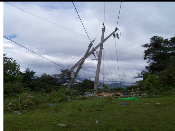
Estructuras 69KV derribadas
