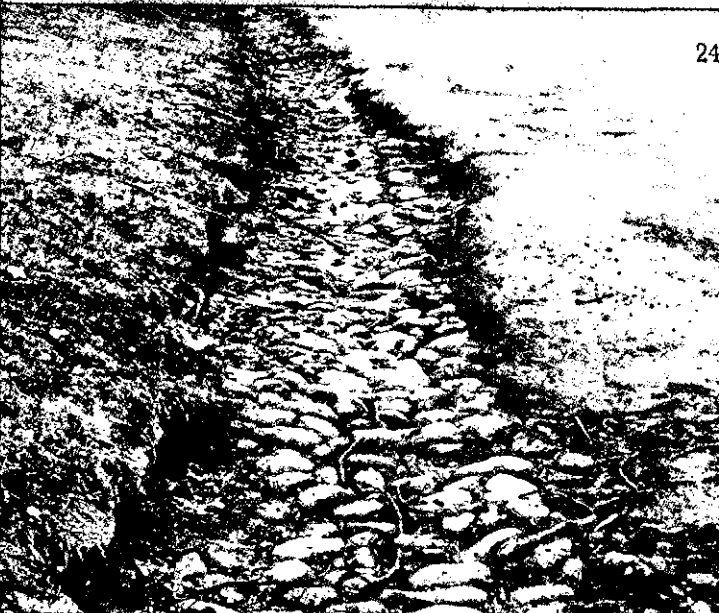
19. Camino sin cunetas y con los hombros a mayor altura que la vía transitable. Se hallará en muy malas condiciones durante la estación de lluvias porque no podrá eliminarse el agua acumulada / 20. Camino construido hace dos años y en malas condiciones por la falta de dragado / 21. Acceso a una propiedad particular peligroso para el tránsito. Se observan las amplias tuberías colocadas para no interrumpir el desagüe de las cunetas. Los hombros angostos pueden causar, en cambio, accidentes / 22. Acceso bien construido a una propiedad particular / 23. Cuneta revestida / 24. Otro tipo de revestimiento para cuneta.
