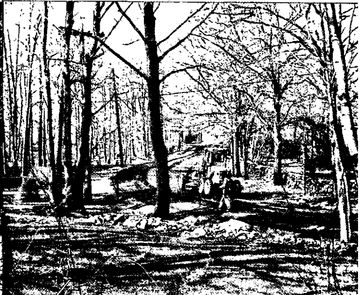
25. Camino sin drenaje que resultará intransitable durante la estación de las lluvias / 26. Camino que atraviesa un terreno bien drenado naturalmente / 27. Camino que requiere una capa de arcilla para evitar que la superficie siga desintegrándose. / 28. Primera etapa en el mejoramiento de un camino con la superficie desintegrada y llena de baches. El inconveniente se hubiera evitado si el camino se hubiese dragado con regularidad / 29. Las patrullas para el mantenimiento de caminos deben disponer del equipo necesario para retirar árboles derribados y obstáculos del camino / 30. Conformación con motoniveladora.
