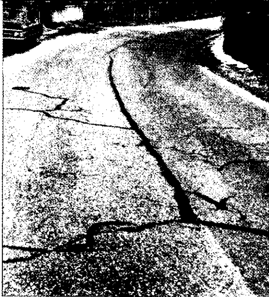
67. Concreto astillado / 68. Concreto astillado / 69. Grieta en el concreto / 70. Grieta longitudinal / 71. Pavimento de concreto destruido por hundimientos debidos a un mal drenaje y a fallas en el suelo.
