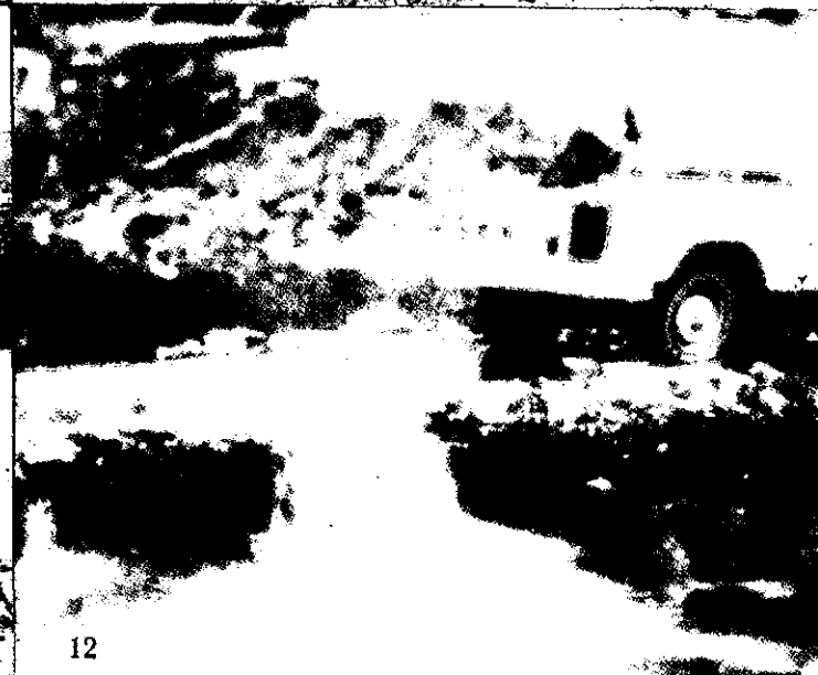
7. Camino sin drenar: el terreno rocoso se utilizó apropiadamente pero hubiera sido preferible hacer más profundas las cunetas y haber recubierto los salientes rocosos con una capa de tierra / 8. Camino de arcilla en una zona de escasas lluvias. Sección de un camino transitable en todas las estaciones del año por haberse mezclado el suelo con arcilla y hallarse en una zona poco lluviosa / 9. Camino de tierra lodosa: estado en el que queda después de una lluvia ligera. Este camino se volverá intransitable en la época de lluvias intensas / 10. Erosión producida por corrientes de agua en zonas volcánicas. Los daños causados por las corrientes copiosas y frecuentes que atraviesan el camino sólo pueden evitarse y repararse construyendo alcantarillas o puentes de tamaño y resistencia adecuados / 11. Vado sin pavimentar / 12. Vado construido con gaviones.
