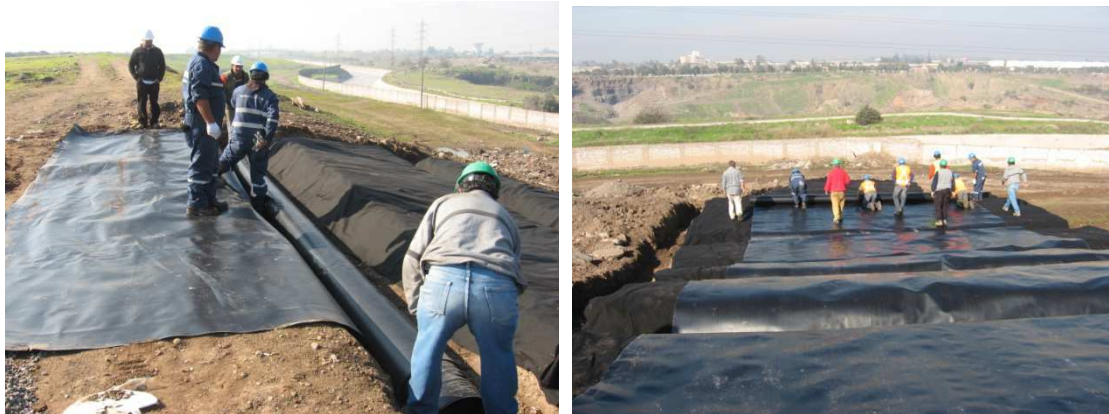
IMAGEN V.8 EX VERTEDERO LO ERRÁZURIZ: IMPERMEABILIZACIÓN DE TALUDES
